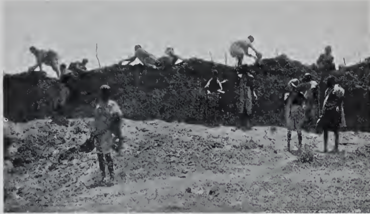
Abb. 14. Bau einer Mauer.
